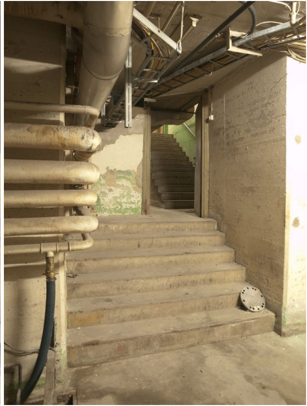
Vindlande kulvertar och trappor i flera nivåer
